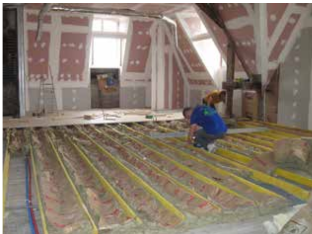
Au 3 e étage, pose du parquet
