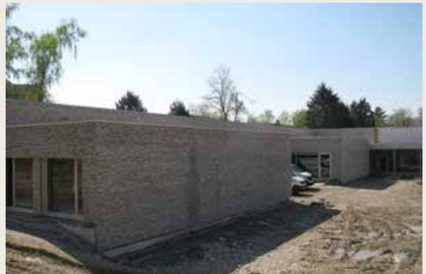
Les briques, côté cour, partie élémentaire
