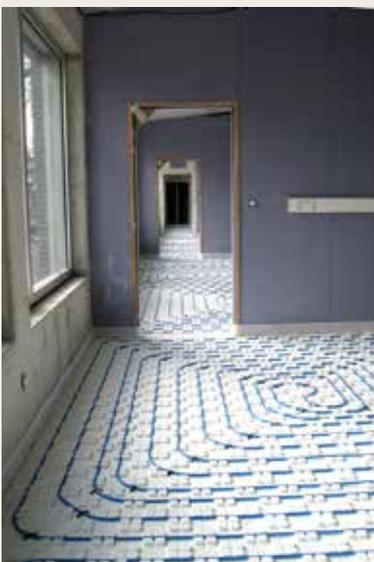
**Les tubes hydrauliques du plancher chauffant sont en place**
