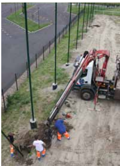
Pose de filets pare-balls au terrain de rugby
