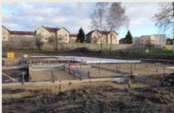
Fin décembre, les fondations et la dalle, côté école primaire, étaient partiellement coulées
