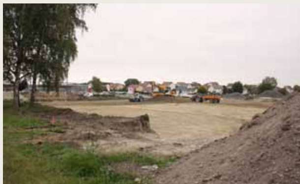
De septembre à octobre, les engins s'activent au terrassement de la plateforme du bâtiment
