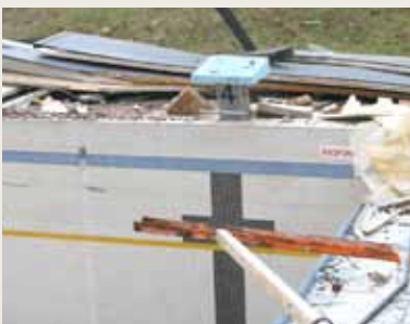
Démolition de la piscine : une page se tourne
