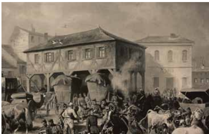
Les halles de Vouziers en 1872 sur la grand place (place Carnot actuelle)
