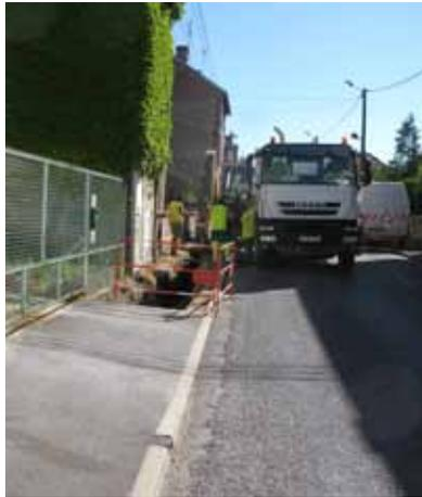
**Réseaux rue du Chemin Salé :** Les travaux de dissimulation des réseaux aériens, électricité basse tension et téléphone, sont réalisés à 90 % par la Fédération départementale des Energies des Ardennes (FDEA).
