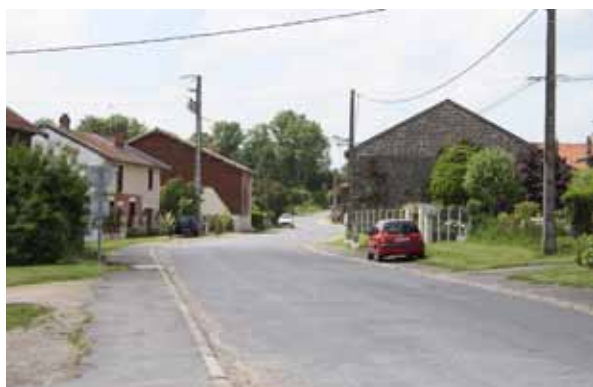
Réhabilitation de la rue Émile Heren à Vrizy : Mise aux normes du réseau eau potable, enfouissement des réseaux aériens, voirie...
