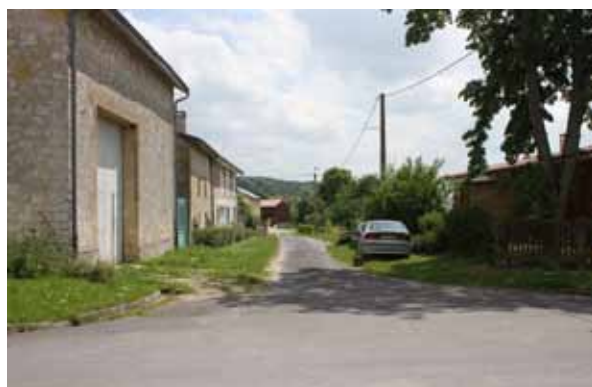
Rues de la Vigne, de Prague, Grande-Rue à Terron-sur-Aisne : réhabilitation, enfouissement des réseaux aériens, éclairage public.
