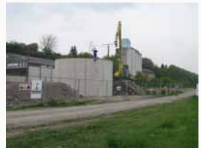
6 mai : Le cylindre est décoffré et commence à s'enfoncer.
