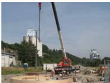
16 juillet : Le cylindre est enfoui. Coffrage de la dalle de couverture.
