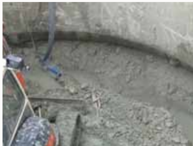
Creusage à la base du tubage à l'intérieur du cylindre pour sa descente
