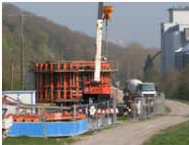
22 avril : construction du cylindre en béton.
