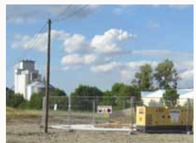
29 juillet : Reste quelques travaux d'équipement et le clôturage.
