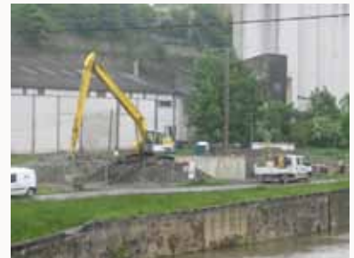
23 mai : Le cylindre est déjà bien descendu, reste encore 2 m.
