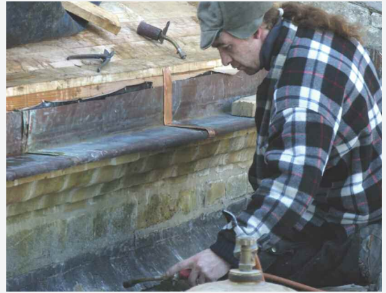
Février - mai 2008 : Avant-nef. Pose de l'entablement cuivre devant recevoir la gouttière.
