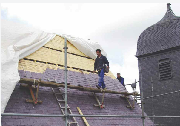
Septembre 2007 : la nef versant nord. Échafaudage mobile remonté par des cordes au fur et à mesure de l'avancement de la couverture.
