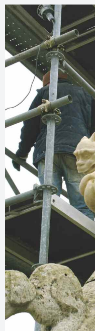
Décembre 2007 : installation des chimères sur les rampants du pignon nord du transept
