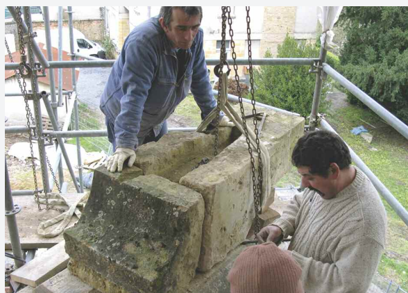
Décembre 2007 : remontage et consolidation du pinacle nord-est.
