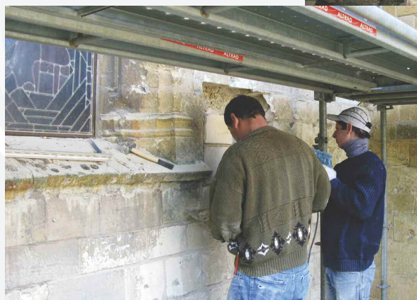
Novembre 2007 : remplacement de pierres dégradées.
