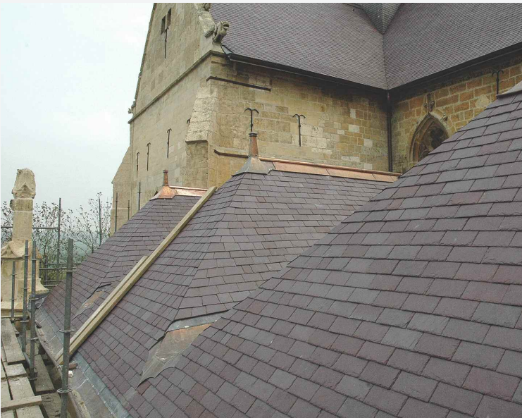
Epi de poinçon et faîtage en cuivre des bas-côtés nord.
