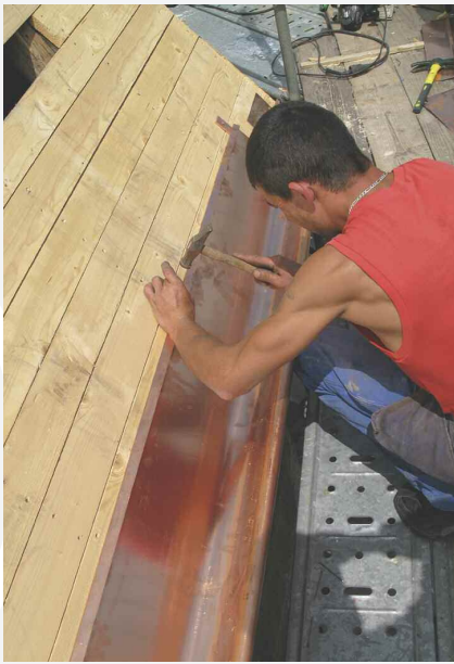
Le chœur : pose des pattes de fixation de la gouttière en cuivre.
